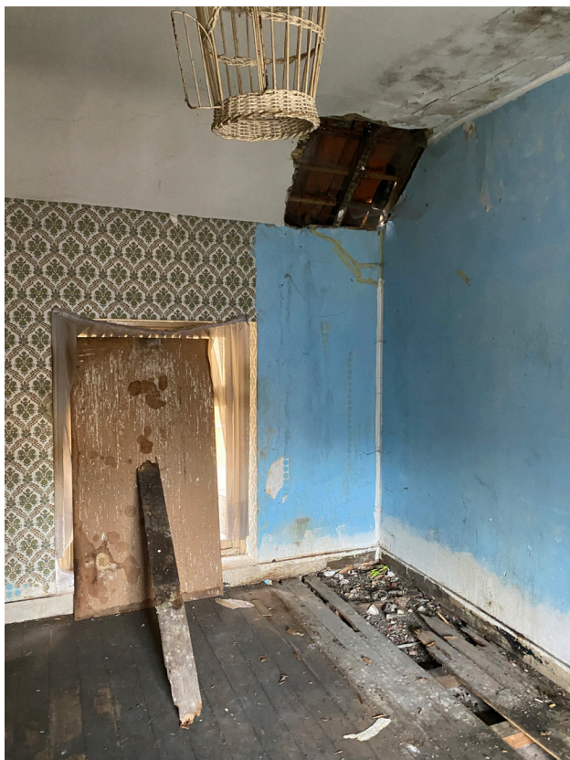
PHOTO 5 Intérieur du volume. Murs pas droits, infiltration d'eau, sols endommagés
