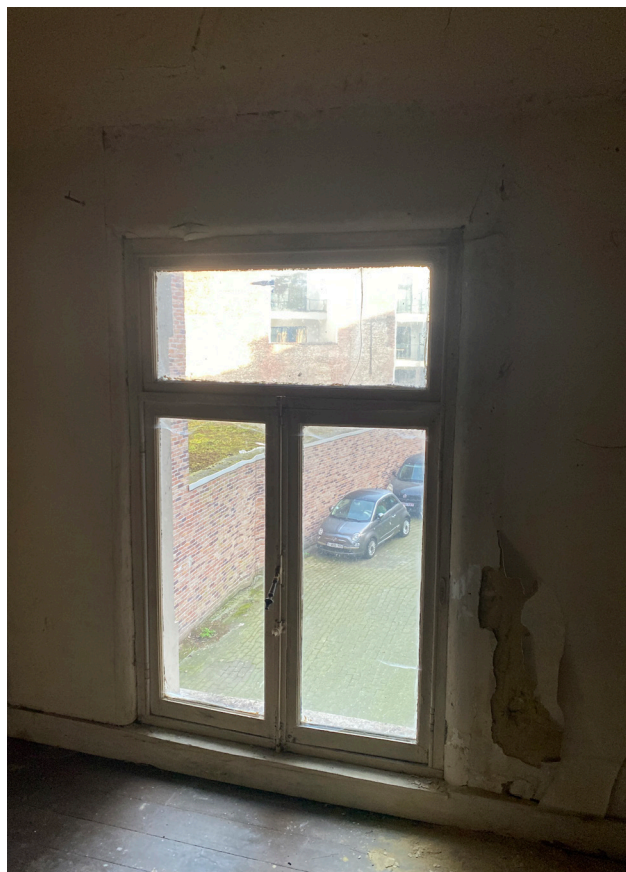
PHOTO 6 Châssis anormalement bas, non conforme.
